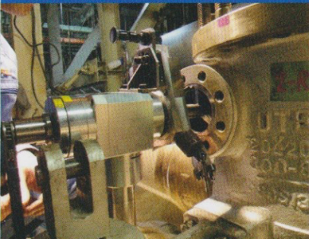
軸受部ガスケット面加工
