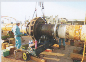
■ 掘削作業船Telescopic補修 パイプ切断・開先加工【径φ100～φ1200】
